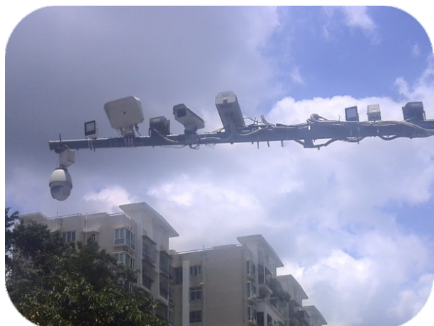
杭州滨江区网商路
